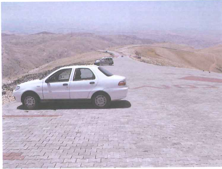
Fotoğraf-12: Beton parke ile kaplanan yol
